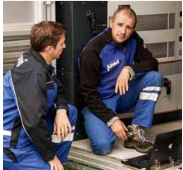
Peter Burghardt (l.) und Thomas Fliege beim Serviceeinsatz im Solarpark.
