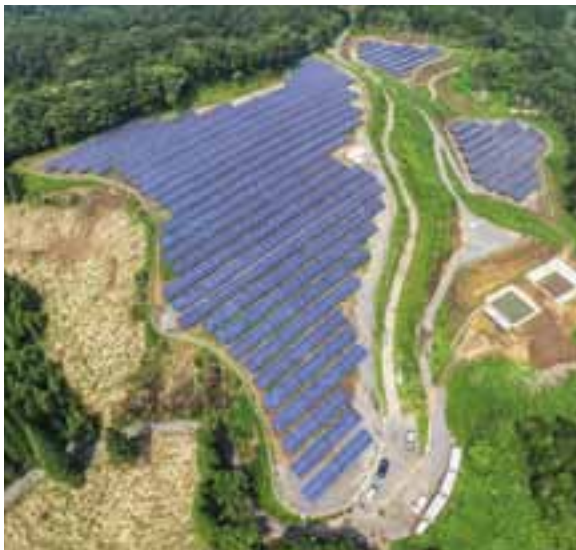
1,6 Megawatt Solarfläche auf der südjapanischen Insel Kyushu.
