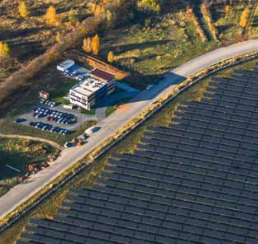
Zwischen den Büros und dem Solarpark in Brandis liegen nur wenige Meter.
