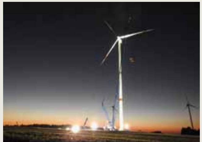
Nachtschicht am Windpark Thalmässing in Franken.
